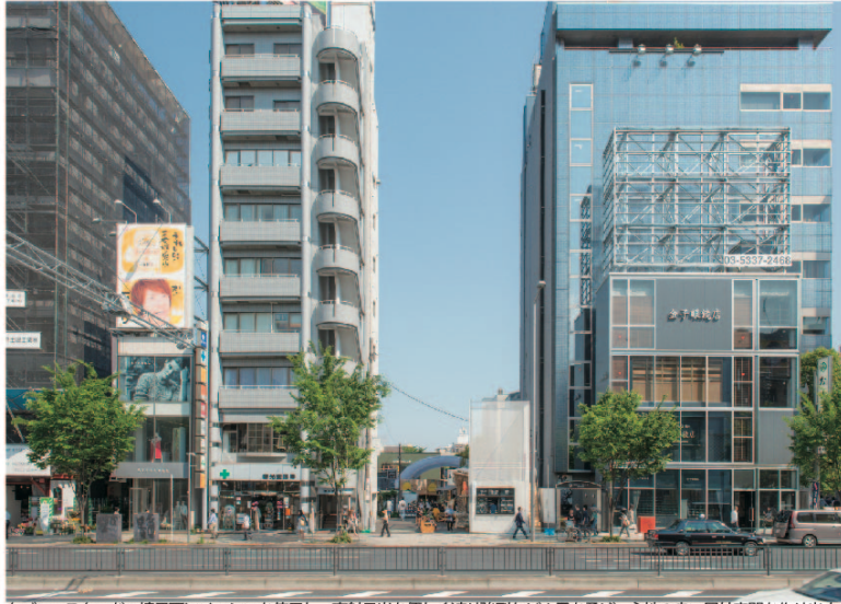
タバコ・スタンド：境界面にメッシュを使用し、直射日光を優しく遮り強烈なビル風を柔げ、心地の良い屋外空間を作り出す。
